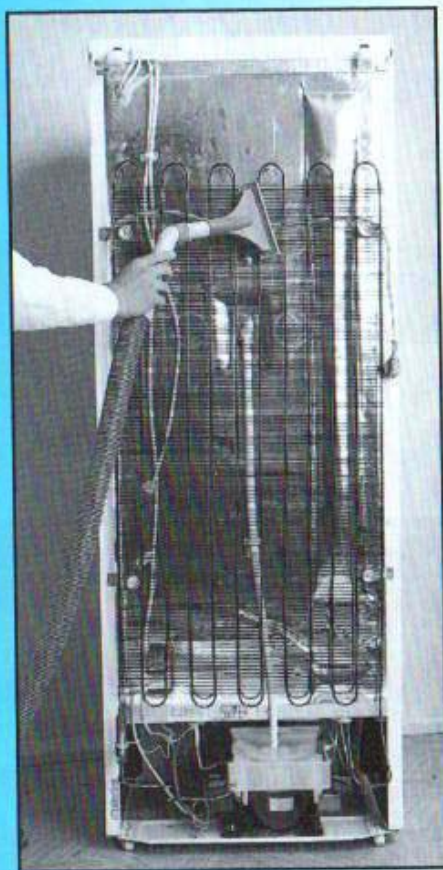
Рисунок 2 - Уборка холодильника (вид сзади)
